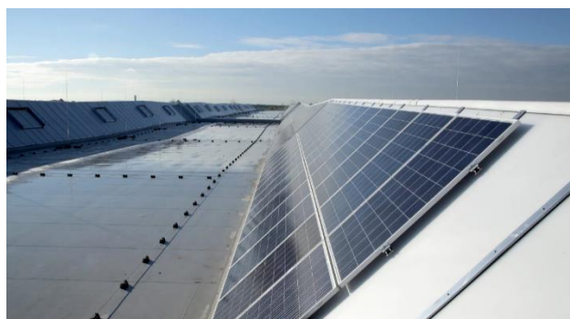
Figura 55: Foto rappresentativa dell'installazione di impianto fotovoltaico sui lucernari di copertura
