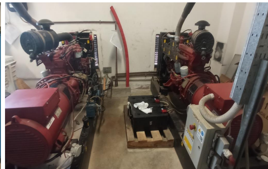
Figura 38: Gruppi elettrogeni esistenti
